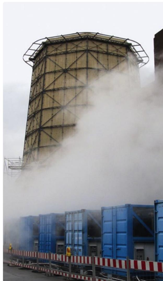
len Kühltürme konnte das Unternehmen die Kälteversorgung seiner Produktionsanlage bis zum Wiederaufbau des Holzkühlturms im Dezember 2011 überbrücken und die sensiblen Produktionsprozesse absichern.
