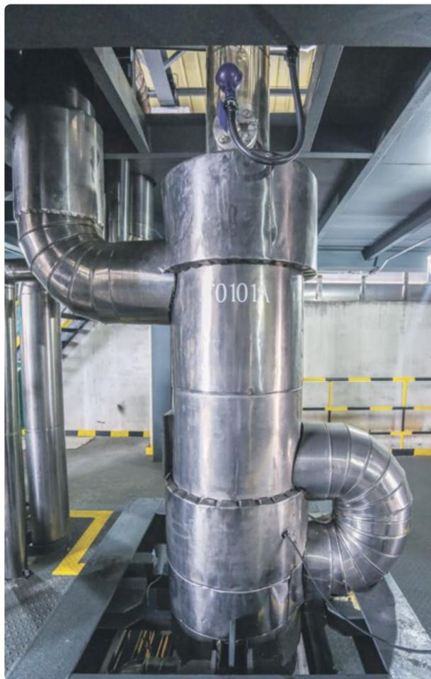
Oberes Ende des 7,50 m langen Miprowa-Reaktors von Ehrfeld Mikrotechnik bei Shaoning Eastlake High-Tech in China mit äußeren Verbindungen des Temperiermediums.
