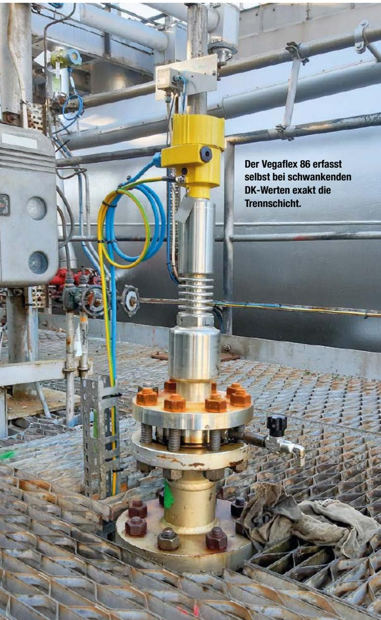
Der Vegaflex 86 erfasst selbst bei schwankenden DK-Werten exakt die Trennschicht.
