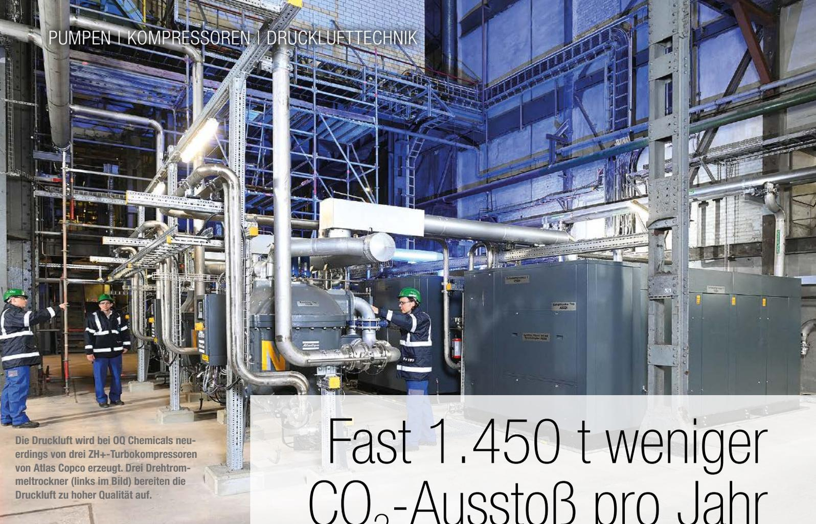
Die Druckluft wird bei OQ Chemicals neuerdings von drei ZH+-Turbokompressoren von Atlas Copco erzeugt. Drei Drehtrommeltrockner (links im Bild) bereiten die Druckluft zu hoher Qualität auf.
