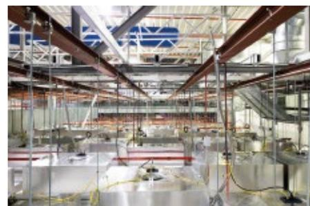
Abb. 1: Das Plenum über dem Reinraum
