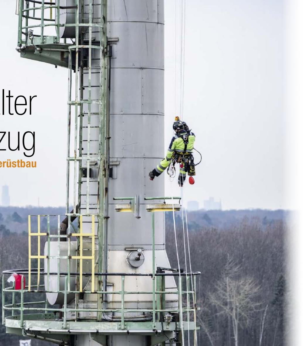
Die Industriekletterer von Bilfinger haben an einer Kolonne ein Heizband und die dazugehörige Isolierung an einer Leitung ausgetauscht. Ausgangspunkt des Manövers war die oberste Plattform der Anlage in 30 m Höhe, von der sich die Fachkräfte abseilten. Statt ein Gerüst aufzubauen, führte das Serviceteam die Wartung mit den Kletterern in sehr kurzer Zeit und mit einer deutlichen Kostenersparnis für den Auftraggeber aus.
