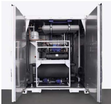
Auf der Hinterseite ist der Maschinenraum platziert. Das Bild zeigt die CO<sub>2</sub>-Einheit, welche die Luftschleuse auf -20 °C hält. Dahinter befindet sich die Einheit zur Erzeugung der Tieftemperatur mit Luft als Kältemittel.
