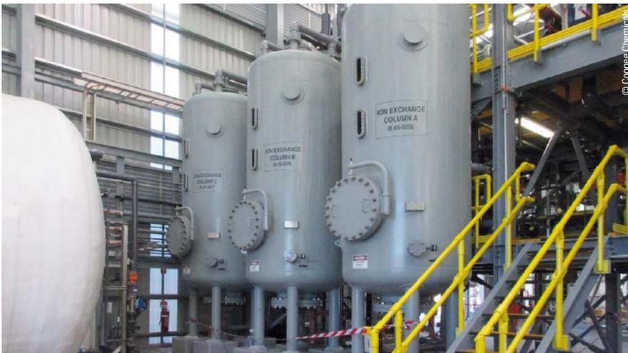
Der Chloralkali-Betrieb der Coogee Chemicals in Lytton, einem Vorort von Brisbane, Australien, ist seit mehr als fünf Jahren mit seiner ersten Harzfüllung in Betrieb und zeigt bis heute gute Leistungen. Die Ionenaustauscher-Kolonnen sind mit dem feindispersen Harz Lewatit MDS TP 208 gefüllt, das die empfindlichen Elektrolysemembranen schützt, indem es Verunreinigungen wie Härtebildner und Barium zuverlässig entfernt.
