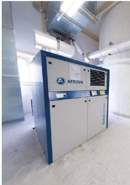
Die Delta Screw Einheiten vom Typ VM21 liefern einen Volumenstrom bis 1.200 m<sup>3</sup> in der Stunde.
