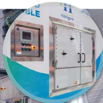
Die Anlage und Einbauprodukte wurden gemäß der europäischen ATEX-Richtlinie zertifiziert.
