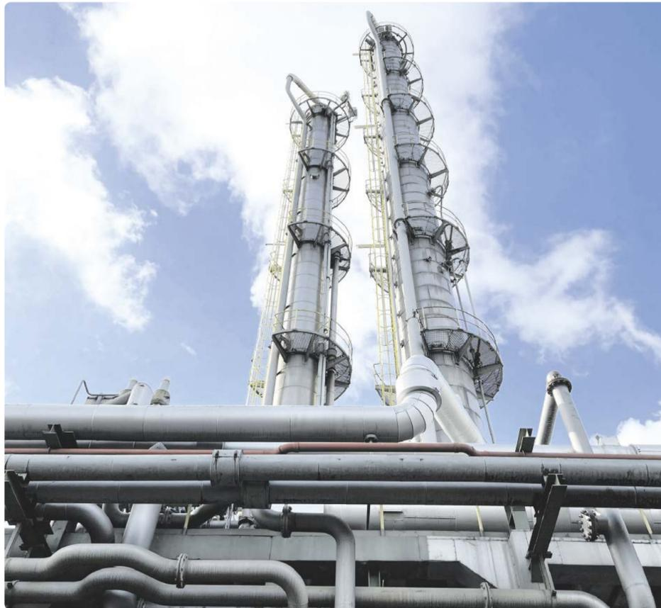
Mittels eines Smart-Safety-Tests an sicherheitsrelevanten Absperrklappen konnte Evonik in Marl die Verfügbarkeit einer Propen-Destillation erhöhen und die Zyklen zwischen Anlagenstillständen von einem auf drei Jahre verlängern.
