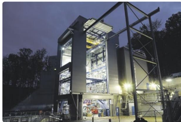
ESA-Prüfstand P5.2 des Deutschen Zentrums für Luft- und Raumfahrt (DLR) am Standort Lampoldshausen in der Nähe von Heilbronn. Hier können die Oberstufen der europäischen Trägerrakete Ariane 6 inklusive Triebwerksheißlauf getestet werden.
