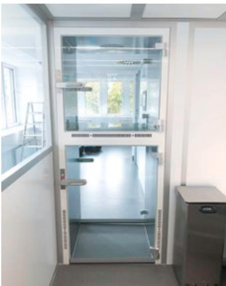
**Abb. 3: Über bodentiefe Materialschleusen werden Materialwägen sicher in den Reinraum eingeschleust.**
