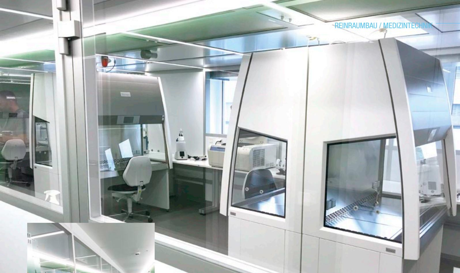
**Abb. 1: Sicherheitswerkbänke im Reinraum gewährleisten eine keimfreie Produktion der Impfstoffe.**
