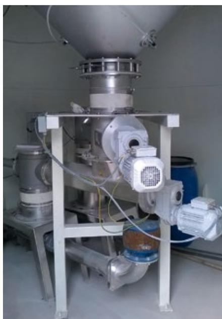
Abb. 4: Parallelaustrag mit Dosierschnecken unter dem Silo
