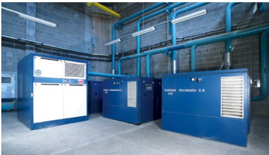
Abb. 3: Vier Drehkolbengebläse in der zentralen Druckluftstation.
