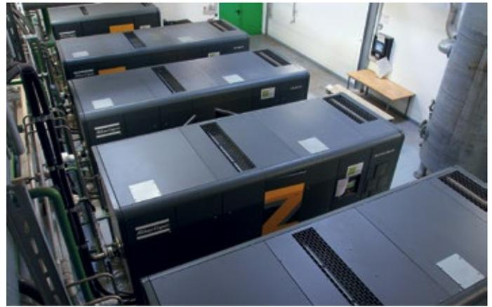
Abb. 5: In der Kompressoren-Station arbeiten insgesamt fünf ölfrei verdichtende Schraubenkompressoren von Atlas Copco – zwei drehzahlgeregelte ZR 315 VSD FF, zwei ZR 250 FF und ein ZR 90 FF. Im Normalfall sind drei bis vier Kompressoren in Betrieb.
