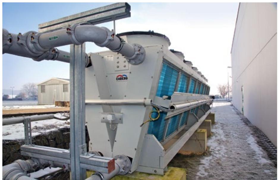
Abb. 6: Die Abwärme der Absorptionskälteanlage gelangt im Sommer auf einen separaten Wasser-Luft-Außenkühler außerhalb des Gebäudes. Im Winter werden die Schaltschränke einfach mit Außenluft gekühlt. ►
