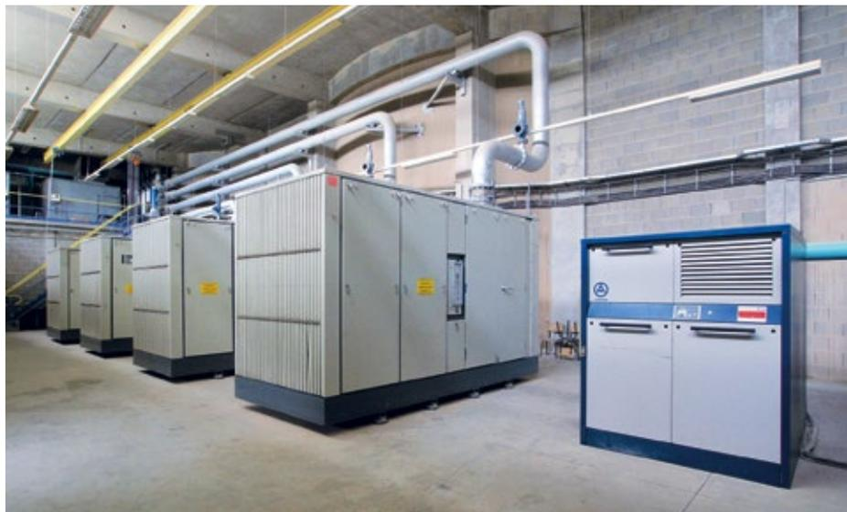
Abb. 4.: Vier Schraubenverdichter und im Vordergrund das Delta-Hybrid-Aggregat.
