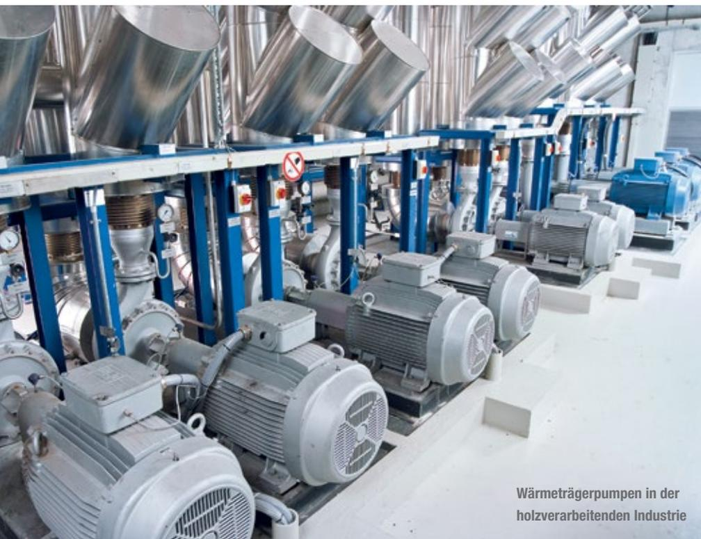
Wärmeträgerpumpen in der Holzverarbeitenden Industrie
