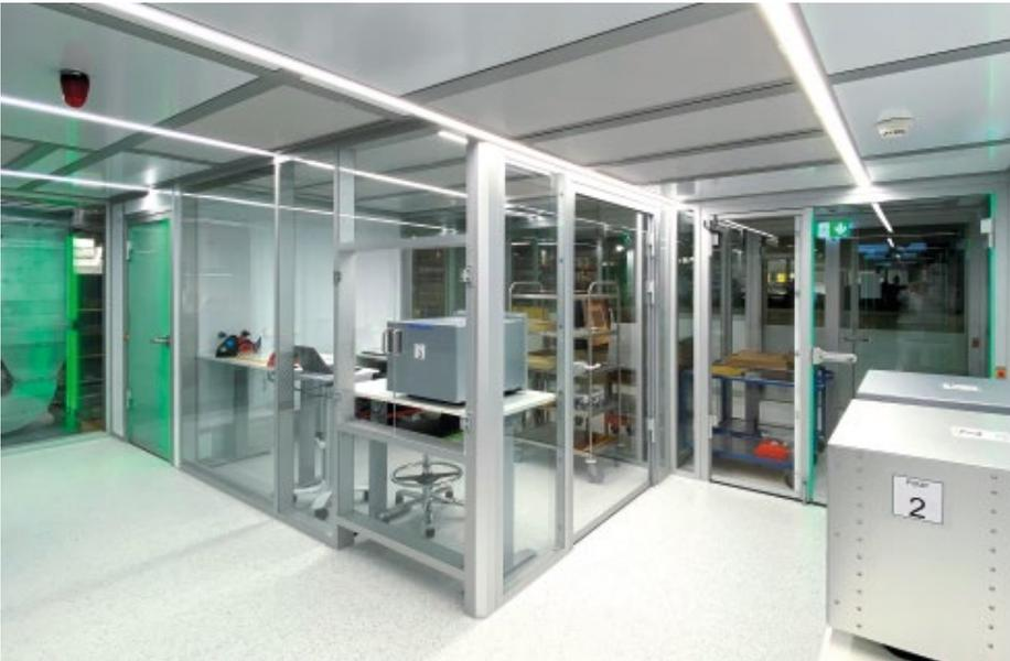
Abb. 1: Vollverglaster ISO-5-Reinraum CleanCell4.0 für die neue Sputteranlage
