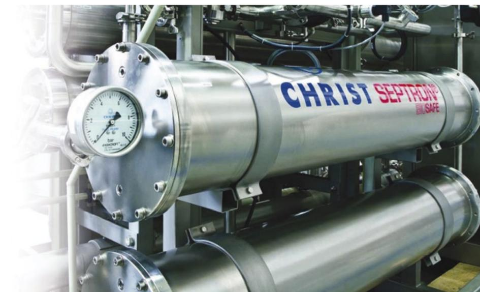
für die Produktion von Reinstwasser eingesetzt. Alle Systemkomponenten können bei Temperaturen von mehr als 80 °C mit Heißwasser desinfiziert werden. Die Verwendung von Chemikalien ist nicht notwendig.
