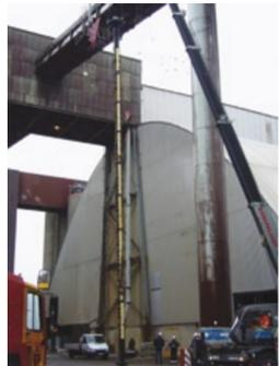
Abb. 2: Zwei Kräne brachten die Pumpe dann von horizontaler in die vertikale Einbauposition. Nachdem die endgültige Vertikal-lage erreicht war, wurde noch ein Kran zur weiteren Installation eingesetzt.
