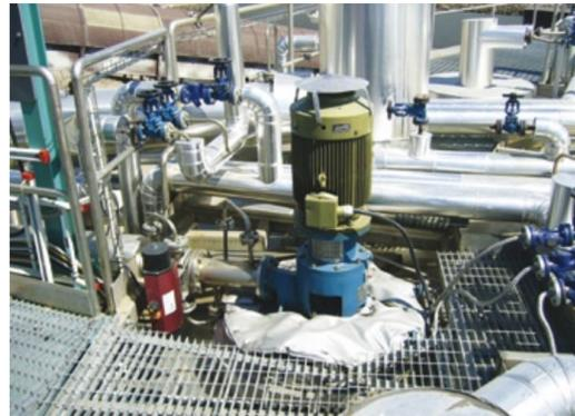
Abb. 3: Die Pumpe nach der Installation auf dem Mannloch des Schwefeltanks. Wegen der Länge der Pumpe musste anschließend eine spezielle dreitägige Aufheizprozedur durchgeführt werden, um Schäden vor der Inbetriebnahme zu vermeiden.
