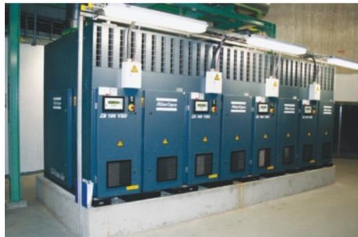
Abb. 2: Vier ZB-Niederdruck-Turbo-Kompressoren von Atlas Copco stellen den Sauerstoffbedarf der neuen Kaskadenbecken in der Currenta-Kläranlage in Leverkusen sicher. Abhängig vom Verschmutzungsgrad des Abwassers laufen zwei oder drei rund um die Uhr; die vierte dient als Sicherheitsreserve. Bei den Turbokompressoren handelt es sich um einstufige, drehzahlgeregelte Maschinen des Typs ZB 160 VSD. Die Motoren sind kontaktlos elektromagnetisch gelagert und arbeiten daher verschleißfrei.
