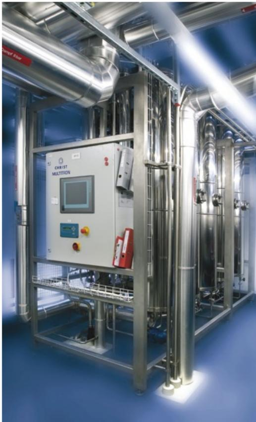
Abb. 1: Zur Turnkey-Anlage gehört auch die Multitron-Destille zur Herstellung von Water for Injection (WFI).
