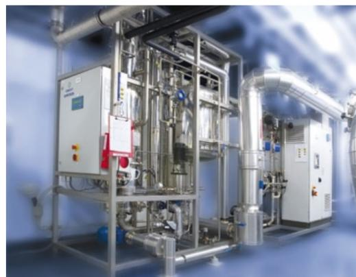
Abb. 2: Ein Reinstdampfgenerator Vapotron und Reinstwasserverteil-Skids (Loopo) sind auch Bestandteil der neuen Wasseraufbereitungsanlage.
