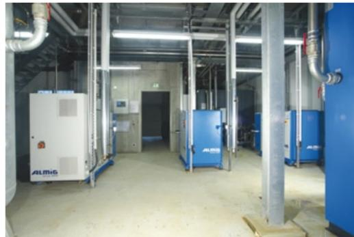
Abb. 2: In der Station 1 arbeitet ein neuer drehzahlgeregelter Almig-Schraubenkompressor des Typs Variable 55 mit  $60\text{ kW}$ -Motornennleistung im Verbund mit zwei festen, ebenfalls neuen Almig-Schraubenkompressoren des Typs Direkt 45 mit je  $45\text{ kW}$ -Motornennleistung.
