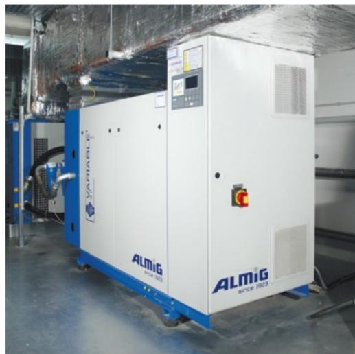
Abb. 3: Für die Druckluft-Station 2 wurde ein neuer drehzahlgeregelter Almig-Schraubenkompressor Typ Variable 37 mit  $50\text{ kW}$ -Motornennleistung installiert sowie zur Steigerung der Versorgungssicherheit (Redundanz-Anlagen) drei kleinere  $22\text{-kW}$ -Anlagen mit fester Drehzahl vom bisherigen Solon-Produktionsstandort übernommen.
