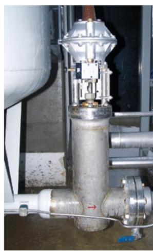
Typ 600 am unteren Auslauf von doppelwandigen Lagertanks
