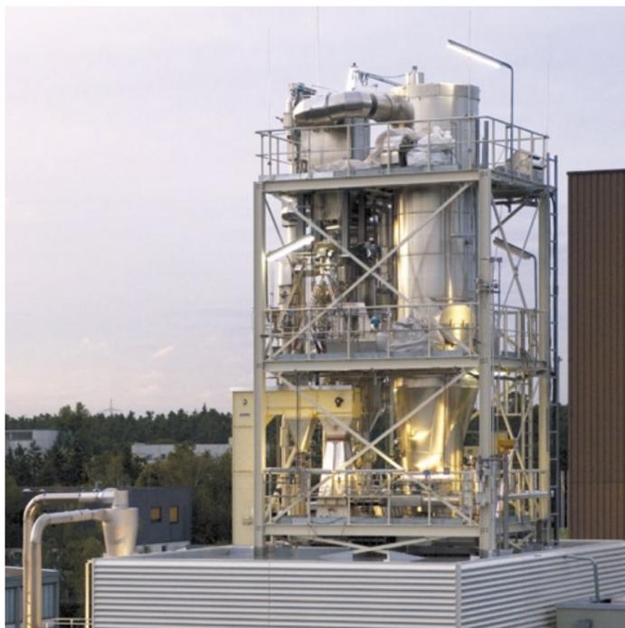
Abb. 2: Teil der Schnellpyrolyse-Stufe zur Herstellung hochwertiger Synthesekraftstoffe.
