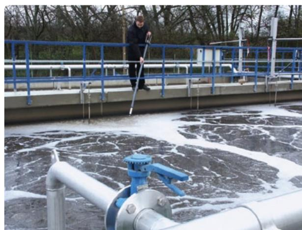
Abb. 3: Sauerstoffmessung in der Kläranlage.
