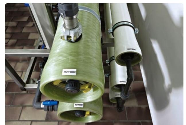
Abb. 2: Das vorbehandelte Wasser wird in eine Umkehrosenose-Anlage eingeschleust (grüne Druckrohre), die es Wasser auf bis zu 98% entsalzt und gleichzeitig Keime zurückhält. Alle drei Stunden werden die Beläge auf der Membran durch die Suck-Back-Technologie zurückgespült und gereinigt (weiße Druckrohre). © Hager + Elsässer
