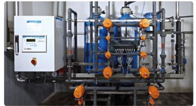
Abb. 1: Das Rohwasser wird zur Aufbereitung zunächst in eine Enthärtungsanlage mit zwei Neutralaustauschern eingeleitet, die in Reihenwechselschaltung betrieben werden. © Hager + Elsässer
