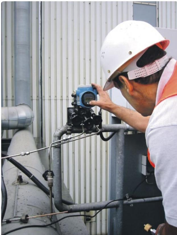
Ein Techniker kalibriert die Messstellenkomponenten des Thermoölkreislaufes. Danach führt er eine Gesamt-Messunsicherheitsberechnung durch.
