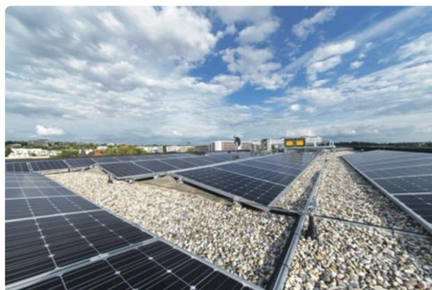
Die gewonnene Energie aus den Photovoltaikmodulen wird für Beleuchtung, Belüftung, Heizung und Kühlung eingesetzt sowie für die Stromtankstellen in der Tiefgarage genutzt.
