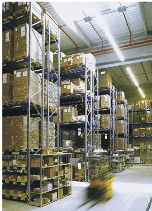
Licht ist ein Sicherheitsfaktor. Lean-Prozesse haben bei Loxxess dazu geführt, dass ausreichende Helligkeit und sparsamer Energieeinsatz zusammenpassen: Die Beleuchtung von Lagergassen wird an mehreren Standorten über Bewegungsmelder geschaltet. Arbeitet mehrere Minuten lang kein Mitarbeiter in einer Gasse, schaltet die Beleuchtung automatisch ab. Nähert sich ein Mitarbeiter, geht das Licht an.
