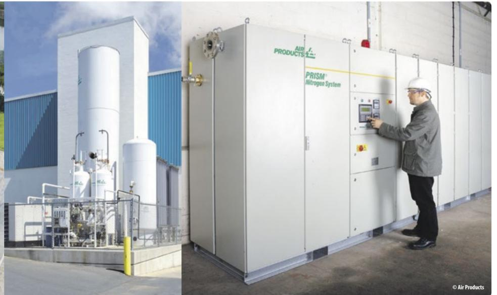
Anwender können zwischen verschiedenen Systemen zur Vor-Ort-Erzeugung von Stickstoff wählen, darunter kryogene Luftzerlegungssysteme (linkes Foto), PSA-Systeme (Foto Mitte) und Membransysteme (rechtes Foto).
