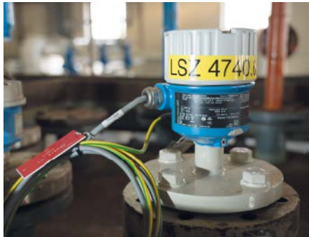
Abb. 1: Mit dem nach SIL entwickelten Liquiphant FTL51 können die Prüfintervalle für die wiederkehrende Prüfung verlängert werden.
