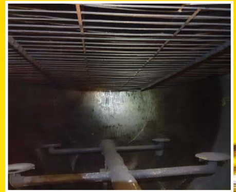
Nach erfolgreichem Testlauf wurde ein weiterer Entsalzer mit einem Vegaflex 86 mit Referenzstrecke in Betrieb genommen.
