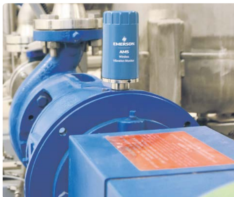
Wireless-Schwingungsüberwachung an Maschinen liefert Informationen, um geeignete Maßnahmen für eine proaktive Wartung zu ergreifen.
