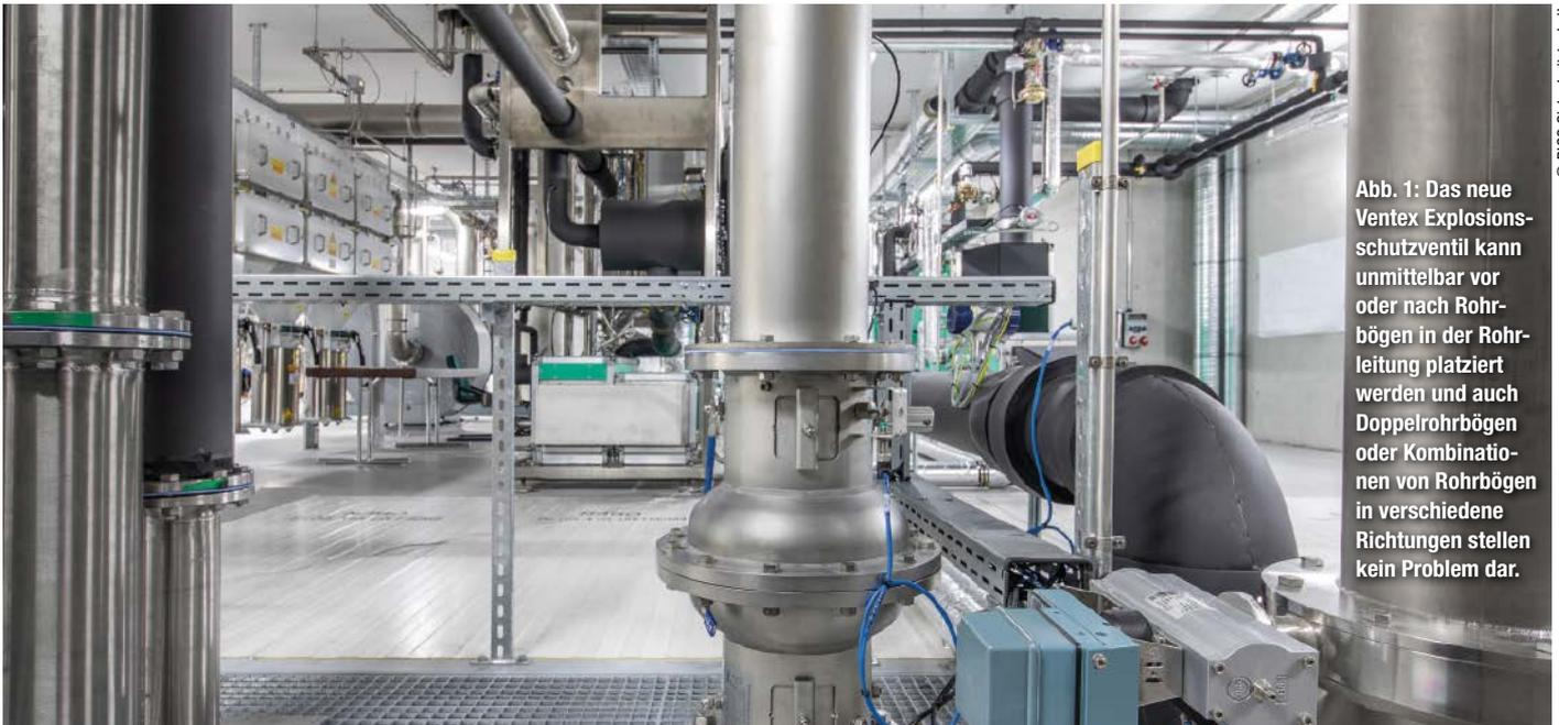
Abb. 1: Das neue Ventex Explosionsschutzventil kann unmittelbar vor oder nach Rohrbögen in der Rohrleitung platziert werden und auch Doppelrohrbögen oder Kombinationen von Rohrbögen in verschiedene Richtungen stellen kein Problem dar.
