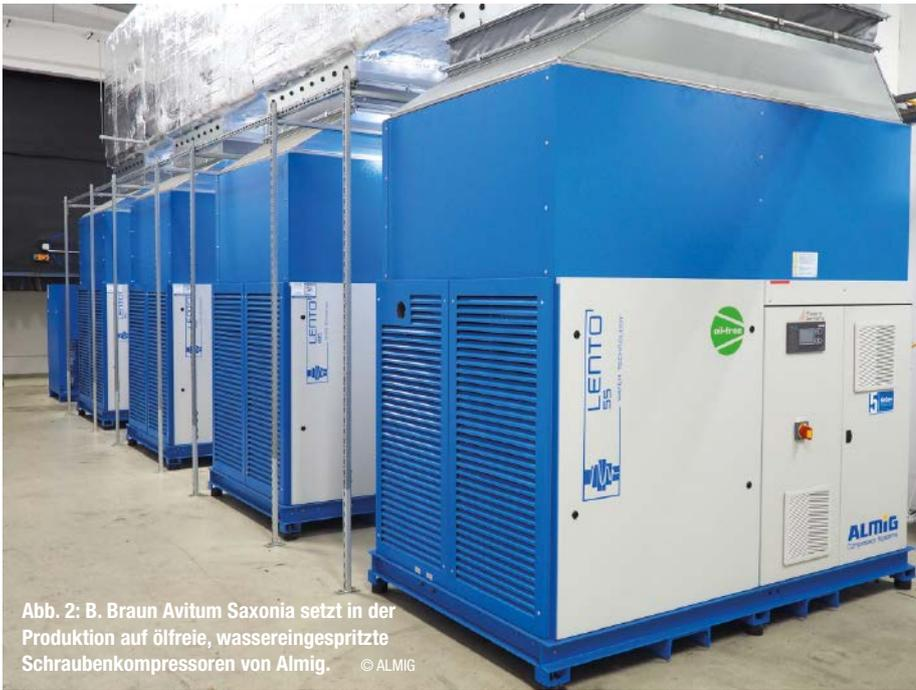
Abb. 2: B. Braun Avitum Saxonia setzt in der Produktion auf ölfreie, wassereingespritzte Schraubenkompressoren von Almig. © ALMIG
