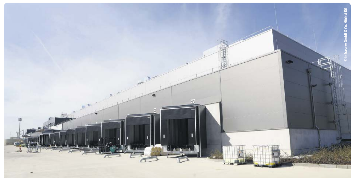
Das neue Gefahrstofflager im Industriepark Höchst setzt Maßstäbe in Bezug auf Sicherheit und Effizienz.
