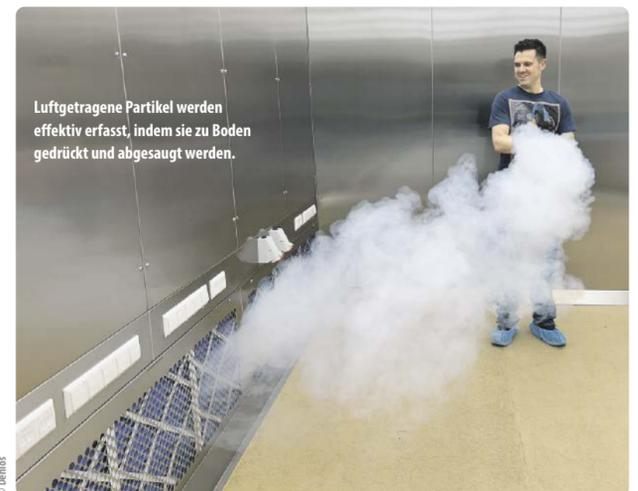
Luftgetragene Partikel werden effektiv erfasst, indem sie zu Boden gedrückt und abgesaugt werden.
