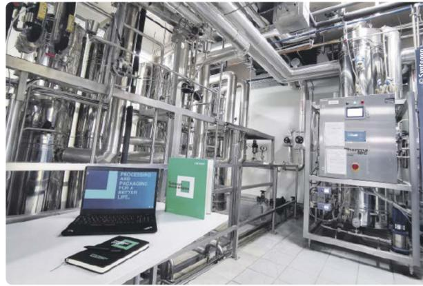
Software-Updates können den Verbrauch an Energie und Wasser bei Destillationsanlagen im Standby-Modus um bis zu 90% reduzieren.
