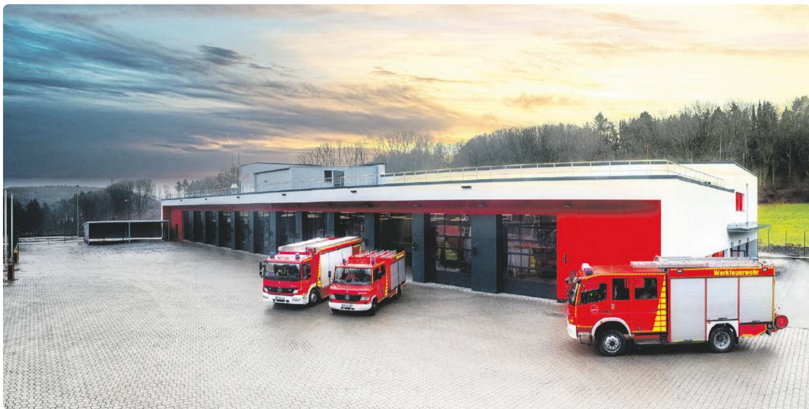
Das neue Werkssicherheitsgebäude in Marburg konnte in Rekordzeit realisiert und im Dezember 2023 bezogen werden.
